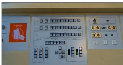
図 8 :N333 操作卓スイッチパネル
