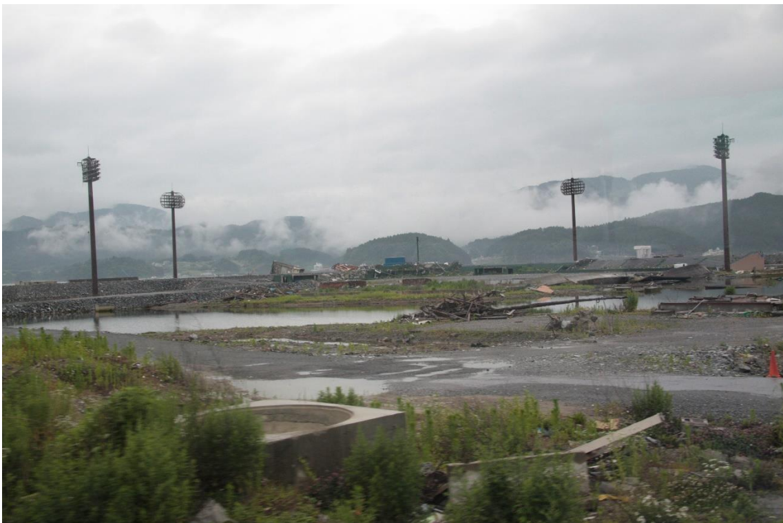
被災した市民球場。東日本大震災直前に完成したものの使用される前に津波で全壊してしまいました。
