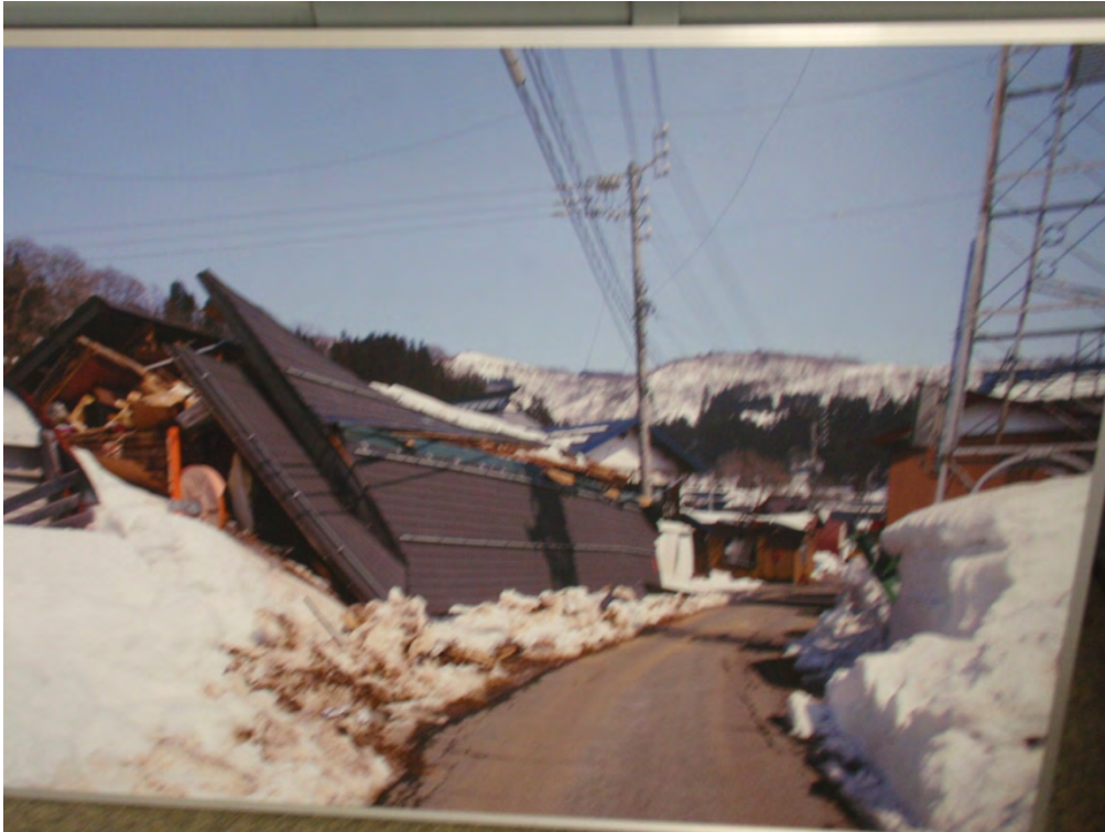
写真 4：全壊した青倉地区公民館の様子 （2011 年 3 月当時）
