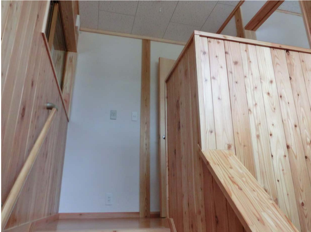
写真5：復興住宅内部2階へ続く階段付近。2階は6畳の部屋が2間設置されている。
