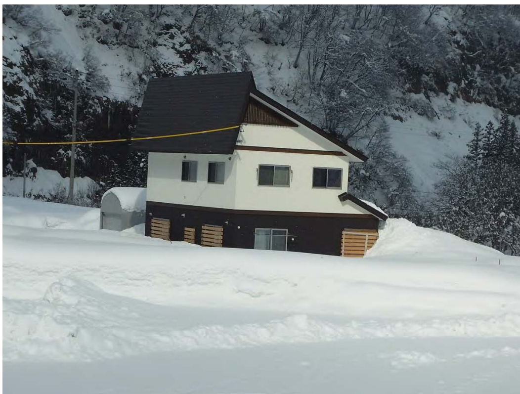
写真4：北野地区に建設された復興住宅。1軒に一世帯のパターンもある。 写真では自然落下式の屋根となっているが、住居が密集する地域では採用されていない。
