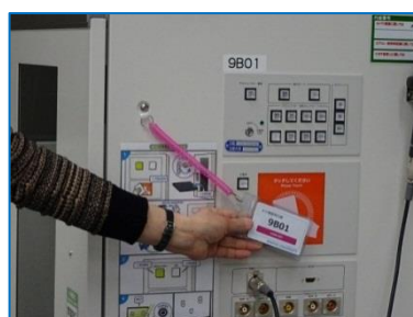
図 10 : 9B01 ・ 9B02 教室 (カード認証システム)
