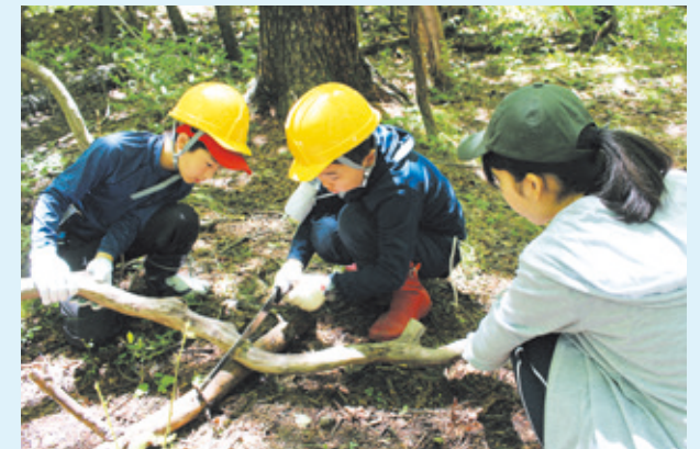
清里の森の中で自然歩道の修復中
